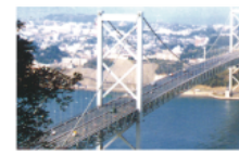
平成5年 日本道路公団：関門橋塔
