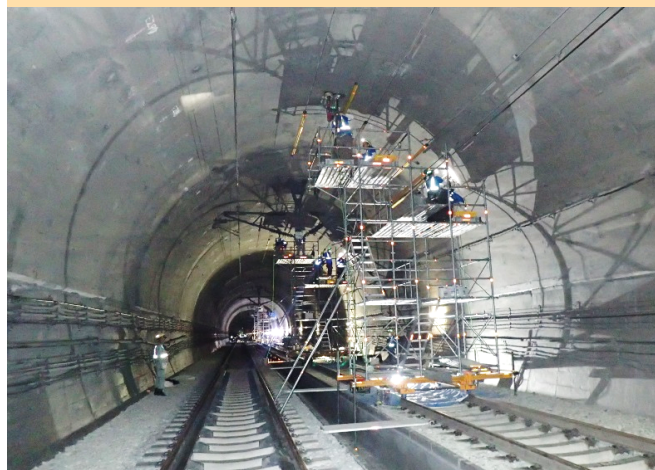
▲新幹線トンネル内 コンクリート補修工事
