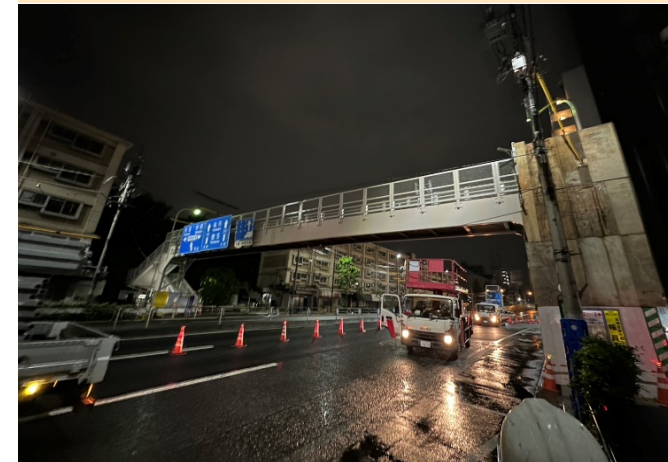
▲歩道橋塗装塗替工事
