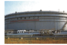
平成3年 関西電力 高砂発電所・貯油タンク
