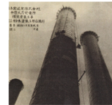
昭和25年 千住火力発電所
