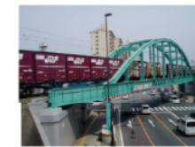
平成26年 博多臨港線 多々良川橋梁
