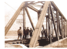
昭和9年 笛吹川橋梁
