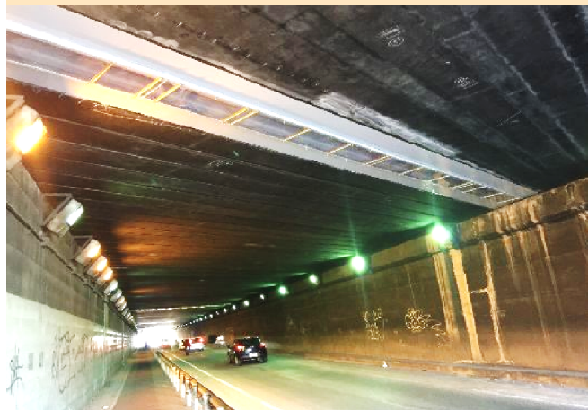
▲トンネル内 コンクリート補修工事
