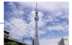
平成24年 東京スカイツリー塔体部
