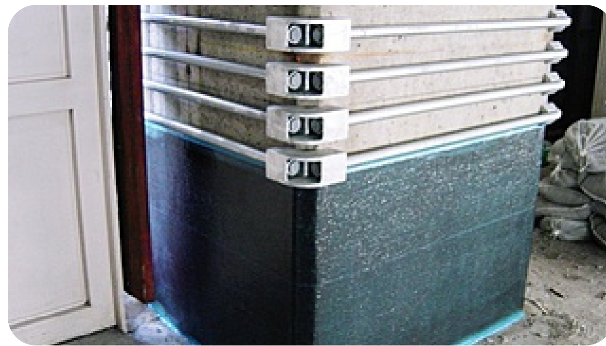
JR広島駅構内耐震補強
