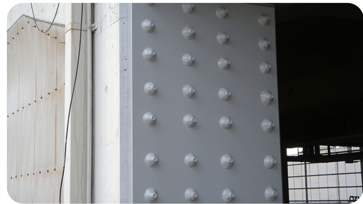
一面鋼板補強工法
